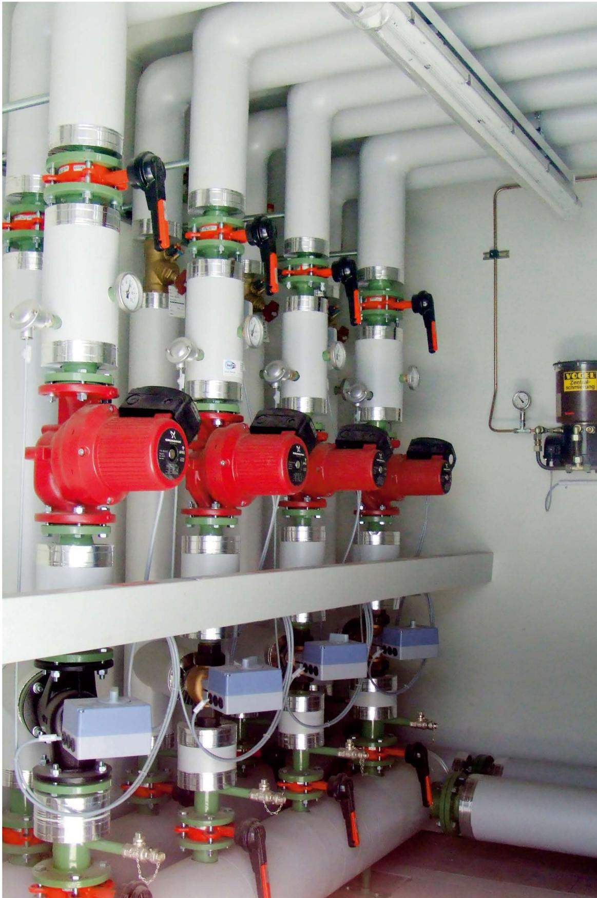
Wärme von BHKW wird an verschiedene Verbraucher verteilt.
